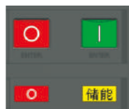
断路器断开且已储能完毕状态
