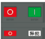
断路器断开且无储能状态
